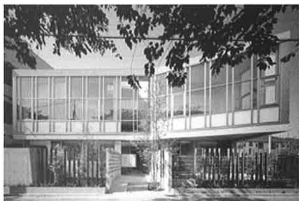
緑道から見た正面ファサード
